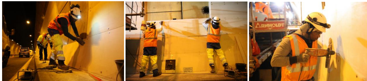
Pose des plaques Aestuver Tx (© NYS. Air Tech Photo. RAZEL-BEC SATELEC)
