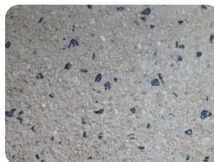
Détails du sol micro-désactivé de l'espace Cobalt à Nevers
