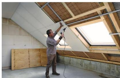
Les plaques de plâtre sont fixées par vissage sur les rails de l'ossature métallique.
