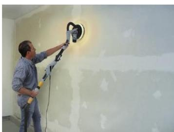
L'excédent d'enduit des joints est retiré après séchage à l'aide la ponceuse télescopique combinée à l'aspirateur pour l'évacuation des poussières.
