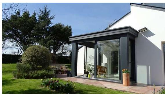
En façade : double vitrage 4/18/4 Fe (faiblement émissif) avec gaz argon
