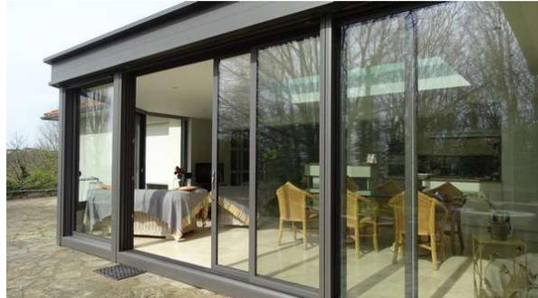
En façade : double vitrage autonettoyant 4/18/4 Fe (faiblement émissif) avec gaz Argon + bardage céramique.
