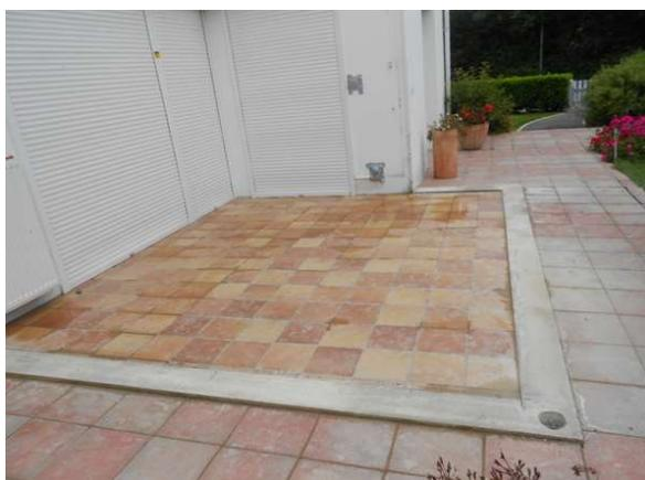
Réalisation du surbau pour assurer l'étanchéité au sol
