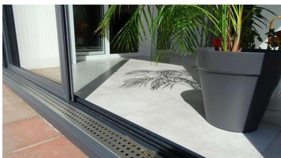
Seuil IN\_OUT au sol, facilitant l'accès entre l'intérieur et l'extérieur de la véranda
