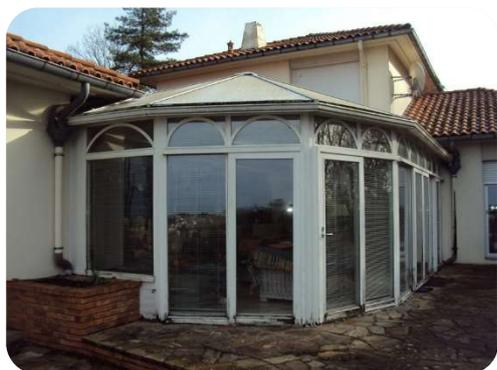
Cette véranda en bois de 40 m<sup>2</sup> avec toiture en polycarbonate, construite il y a 25 ans, était déjà la principale pièce à vivre de la maison, regroupant la cuisine et un grand espace séjour/salon. « *L'usure du toit en polycarbonate a généré des infiltrations d'eau et le manque d'isolation était responsable de grandes pertes de chaleur* », explique Christophe Tricot, de Concept Alu Vendée.
